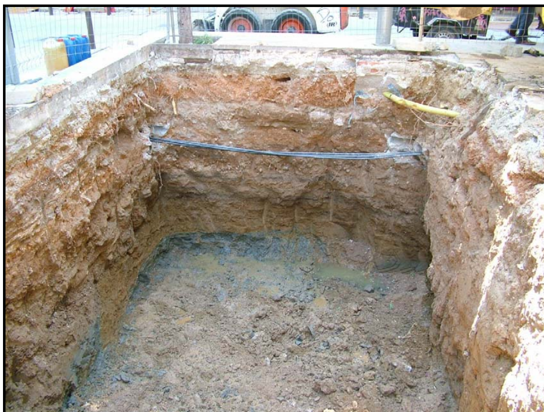
Foto núm. 15. Finalització de l'excavació E.T.2
