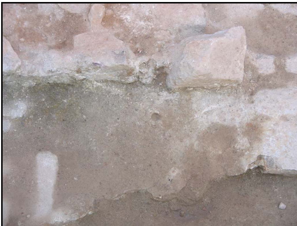
Foto núm. 11 Detall de la base de la polleguera i el paviment UE 26.
